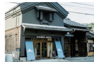
備蓄庫として使われていた築100年を超える蔵を改装。
