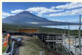
山中湖パノラマ台 施工風景
