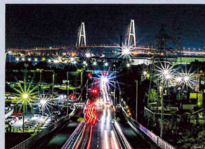
歩道橋から見る 名港トリトンと工場夜景 平洲と大仏を訪ねる花の道 連絡橋
