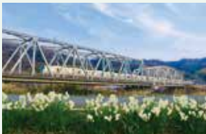
第三大和川橋梁
