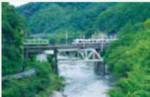
第四大和川橋梁
