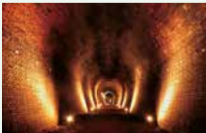
旧大阪鉄道亀瀬隧道
