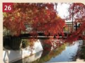
日ノ岡第11号橋
