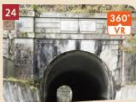
第2トンネル入口
