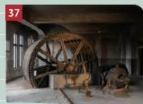
蹴上インクラインダム工場
