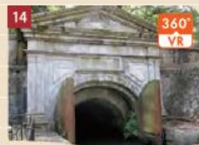
第1トンネル入口
