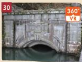
疏水合流トンネル
