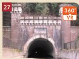
第3トンネル入口
