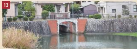
第2疏水取水口と洞門
