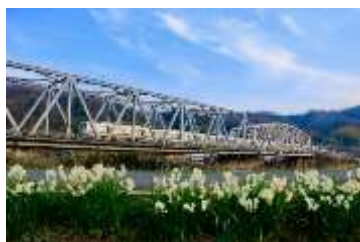
② 第三大和川橋梁
