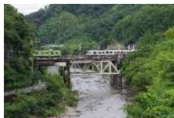
③ 第四大和川橋梁
